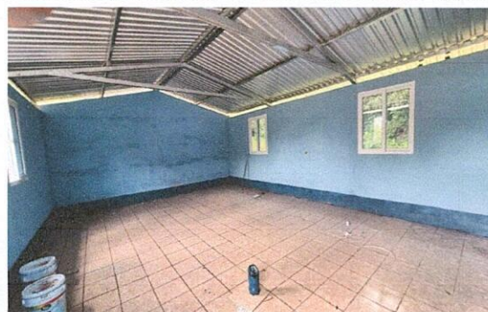
Foto 4: Instalacion de piso cerámico
