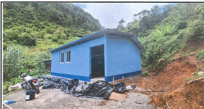
Foto 6: mejoramiento de módulo
