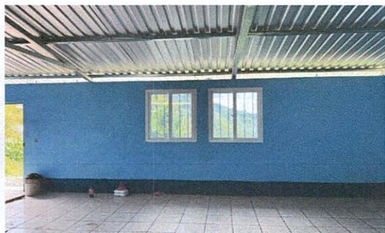
Foto 5: Instalacion de ventanas y balcones
